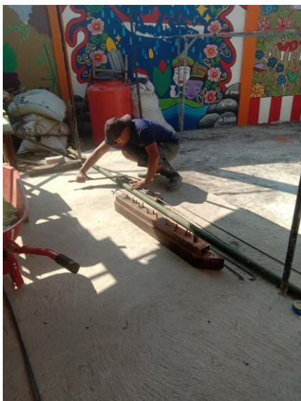
Vorbereiding van de grote renovatie van de sanitaire ruimte in de dovenschool Tunas Bangsa.
